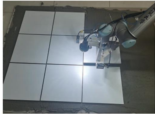
Fig. 7 Colocación de baldosas por el robot (tomado de [25] bajo licencia CC BY 4.0).
