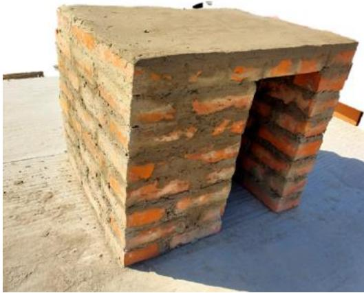
Fig. 4 Estructura construida con ladrillos convencionales.
