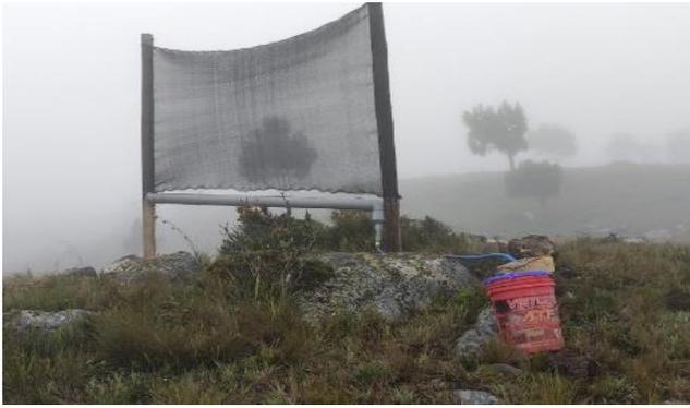
Fig. 4 Instalación del Atrapanieblas con la Malla Raschel
