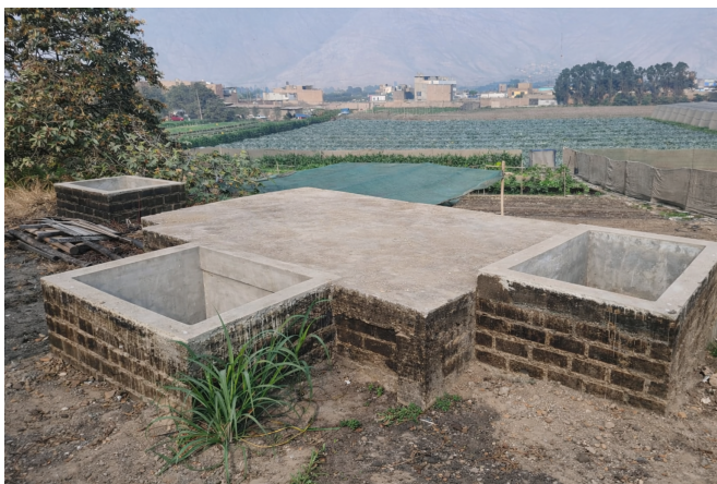
Figura 6: Vista completa del biodigestor tipo chino terminado.
