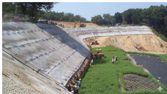
Fig. 10 Esquema del talud N.º 1 con cobertura vegetal de pasto Tanzania ( Panicum maximum ) y con sistemas de refuerzo superficial tipo Geoweb y geomantas MacMat.
