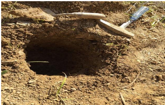
Fig. 5 Calicata realizada para la toma de muestras de suelo y ejecución de ensayos de campo.
