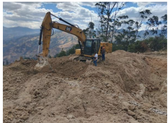
Fig. 2 Maquinaria iniciando trabajos de movimiento de tierra
