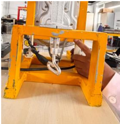
Fig. 9 Instalación del sistema eléctrico
