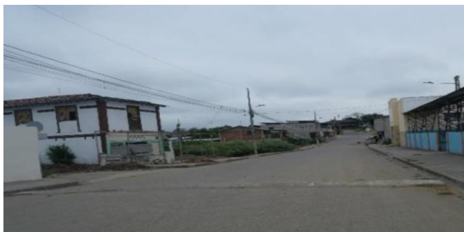
Fig. 5 Reductor de velocidad sin pintura ni señalización en el acceso a San Lorenzo del Mate
