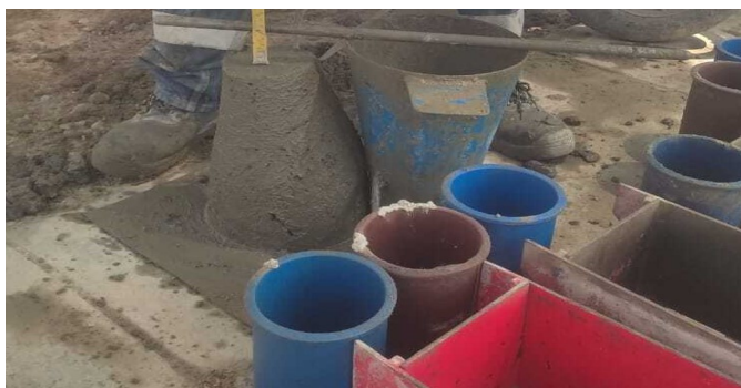
Fig. 4 Ensayo de asentamiento del concreto fresco.
