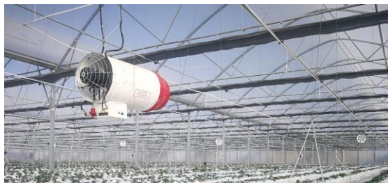
Fig. 3 Sistema de turbos calefactores para el control de la temperatura de los cultivos dentro de un invernadero.
