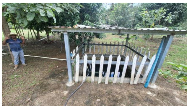
Fig. 3: Manantial con estructura de captación en aldea La Mina.
