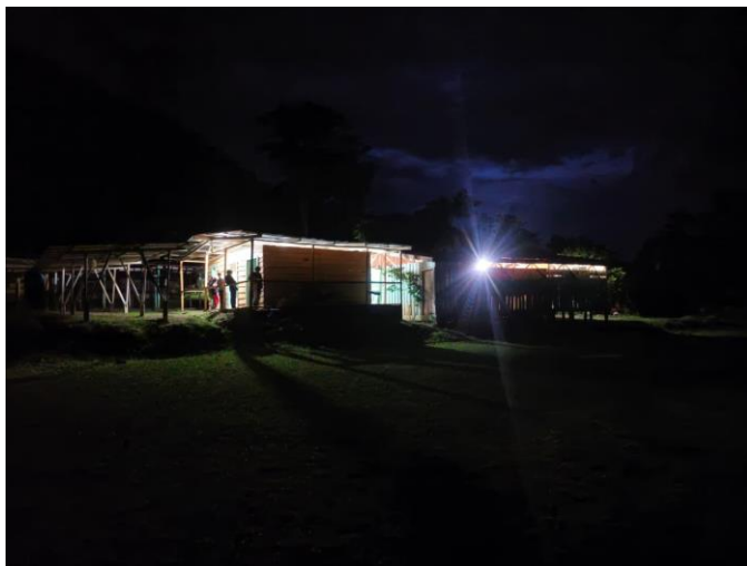
Fig. 3 Centro educativo iluminado por energía solar.
