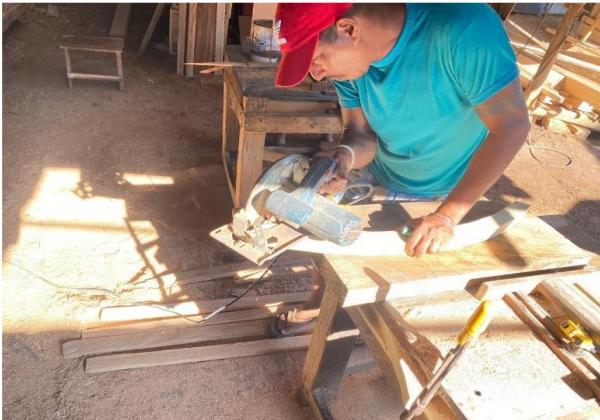
Figura 4. Operario expuesto a vibraciones, posturas estáticas y material particulado (Fuente Propia)
