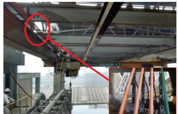
Fig. 2 Sistema de barras del puente grúa de lixiviación
