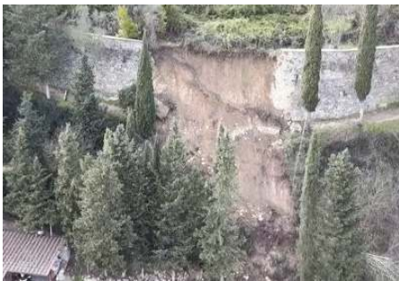
Fig. 6 Vista después del derrumbe en San Gimignano. Adaptado de [12].
