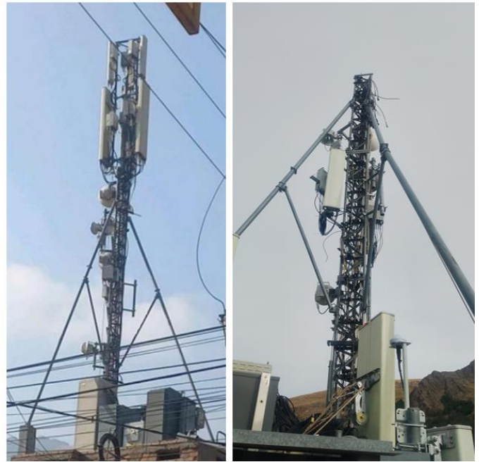
Fig. 01 posicionamiento del mástil y su caída posteriormente.
