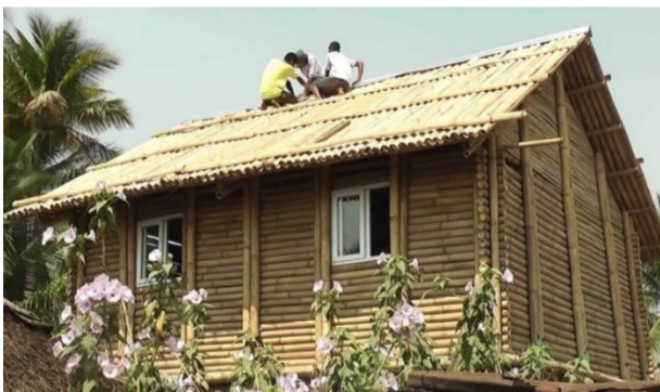
Fig. 2 Ejemplo de vivienda con cerramiento de bambú.
