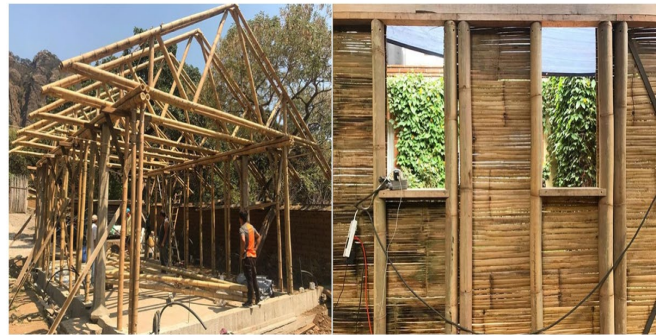
Fig. 4 Detalle del bambú en estructuras y cerramientos.
