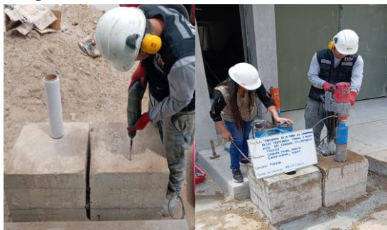
Fig. 05: Proceso de extracción de los testigos de concreto
