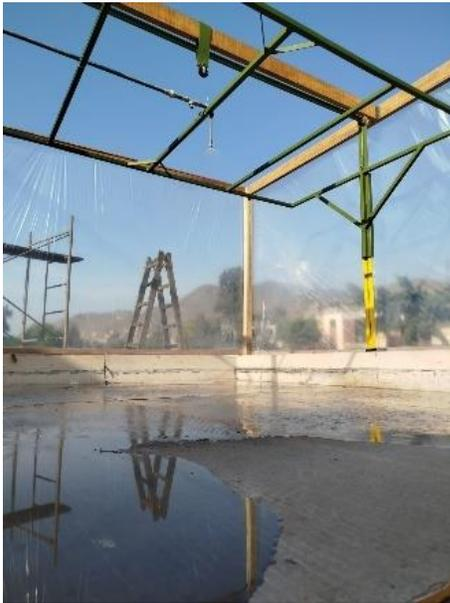
Fig. 3 Sistema de soporte con capacidad de desplazamiento vertical
