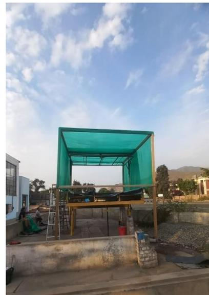
Fig. 4 Estructura adicional de madera y cobertura de malla Raschel 80%
