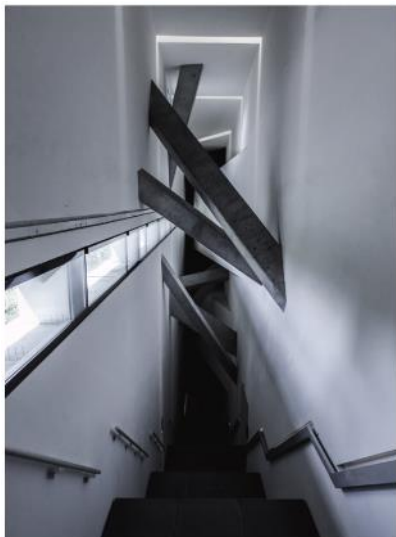
Fig. 7 Acceso de escaleras del “Eje de continuidad” donde se visualizan las estructuras (vigas) de la edificación. Fuente: Plataforma digital de Arquitectura Archdaily (2015).
