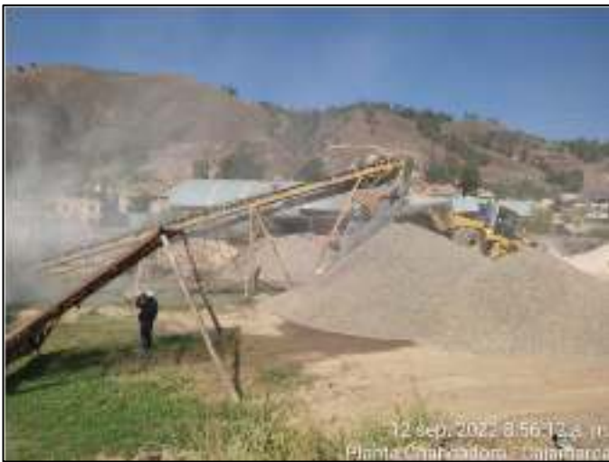
Fig. 3 Agregado de río – Planta chancadora F&C Nikolls.
