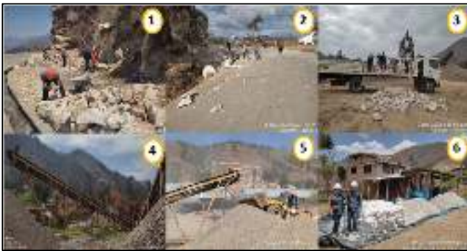
Fig. 2 Obtención de agregado de roca volcánica. (1) Extracción manual, (2) voladura controlada, (3) transporte de material, (4) y (5) proceso de chancado y (6) almacenaje de agregado.
