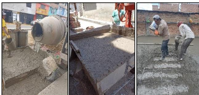
Figura 1. Fotografías de la elaboración del concreto y vaciado en las losas aligeradas en autoconstrucción de viviendas en Cajamarca.
