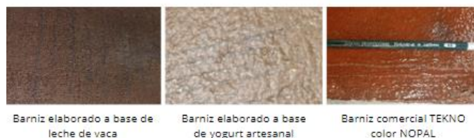
Fig. 9 Resistencia al rayado de los barnices usados en muro de albañilería
