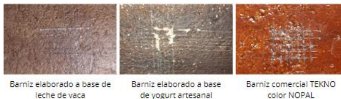
Fig. 3 Resistencia a la adhesión de los barnices usados en muro de albañilería
