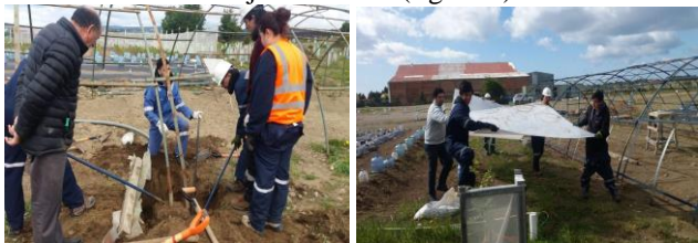
Fig. 6 Trabajos de reconstrucción invernadero en UNPADE.
