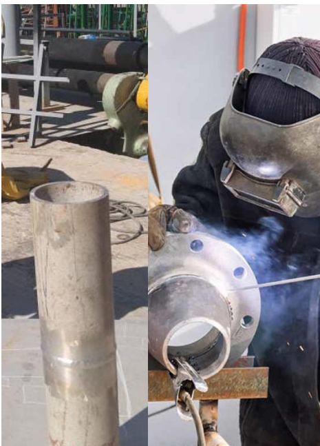
Fig 2. Unión mediante soldadura manual de tubería del mismo diámetro y unión de tubería con brida.
