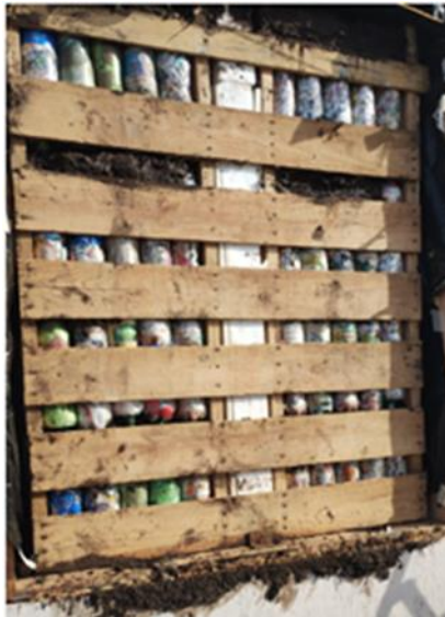
Fig.1 Foto de la pared instalada en la celda de prueba.
