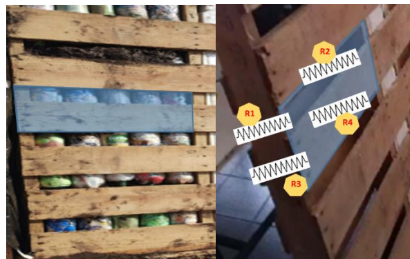
Fig.11 Figura del espacio del ladrillo y las resistencias involucradas.
