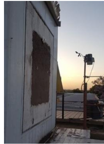
Fig.2 Foto pared cubierta con adobe, sensores de temperatura, medición de radiación solar y estación meteorológica.
