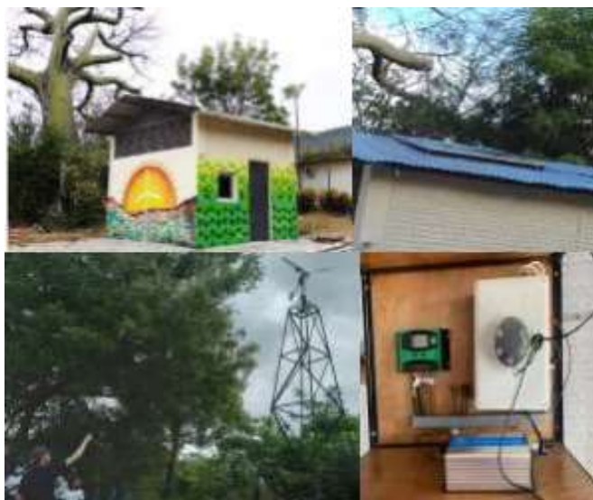
Fig.5 a) casa sostenible b) paneles fotovoltaicos, c) eólico, d) sistema de monitorio y control de las condiciones de confort de la vivienda
