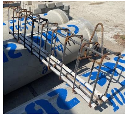
Fig.4 Armado de Viga con adición de bambú.
