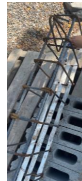
Fig.6 Armado de Viga con sustitución de bambú.
