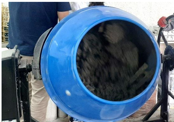
Fig. 5 Preparación de la mezcla de concreto.
