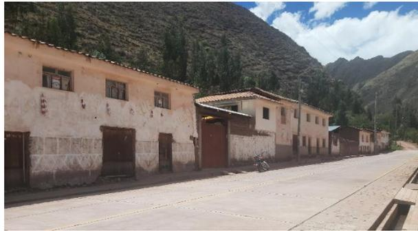
Fig. 3 Vista de elevación de la vivienda típica de adobe
