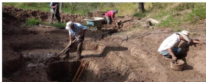
Figure 3. Construcción de la zona de retención de agua y las zanjas de infiltración.
