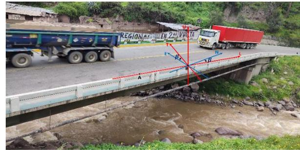
Fig. 4. Transformada de coordenadas topo céntricas a las coordenadas de referencia del puente.
