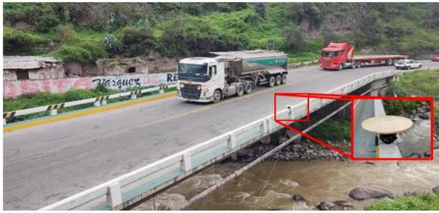
Fig. 3. Antena geodésica en la baranda de concreto del puente.
