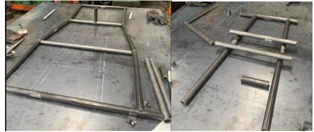
Fig. 18 Fabricación de piso de estructura
