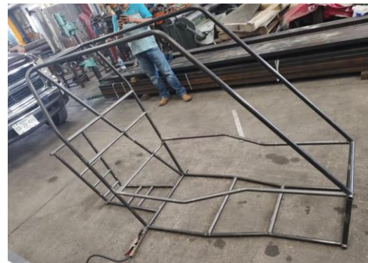
Fig. 19 Fabricación de estructura
