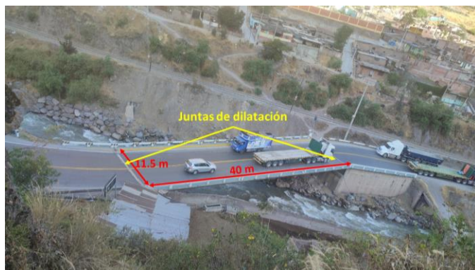
Fig. 1 Puente huaripachi en condiciones normales de operación vehicular. Fuente: Elaboración propia.
