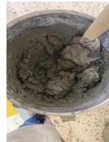
Fig. 4 Mezcla de mortero Fuente: Autores
