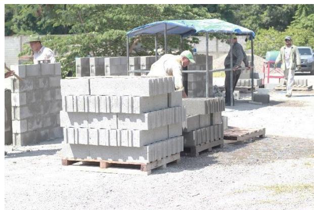
Fig. 7. Bloque C-129 Fuente: Propia
