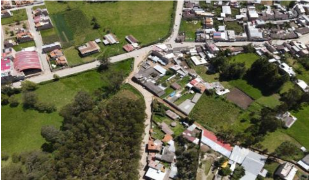
Fig. 4 Fotografía aérea actual de las curvas del Jirón Los Eucaliptos [1]
