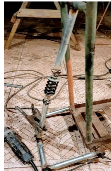
Fig. 7. Finalización de la colocación del amortiguador.
