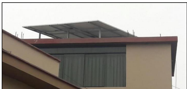
Fig 9. Ubicación de los paneles solares en la vivienda
