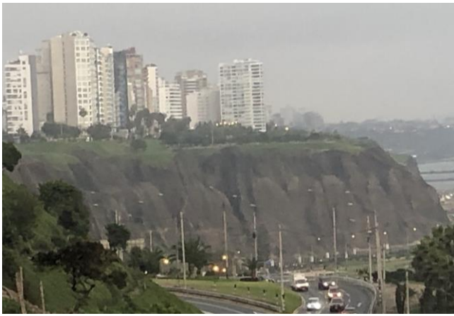
Fig. 1. Acantilado de 50mts promedio de altura y edificios de mediana altura encima.
