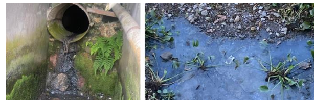
Fig. 12 Cuneta ubicada en el lugar del proyecto
