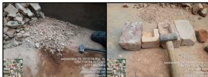
Figura 2: Triturado de los residuos de construcción
