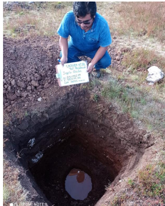
Fotografía 1. Pruebas de Percolación
