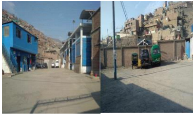
Fig. 4 Zona de descarga y cochera, distintas vistas.
