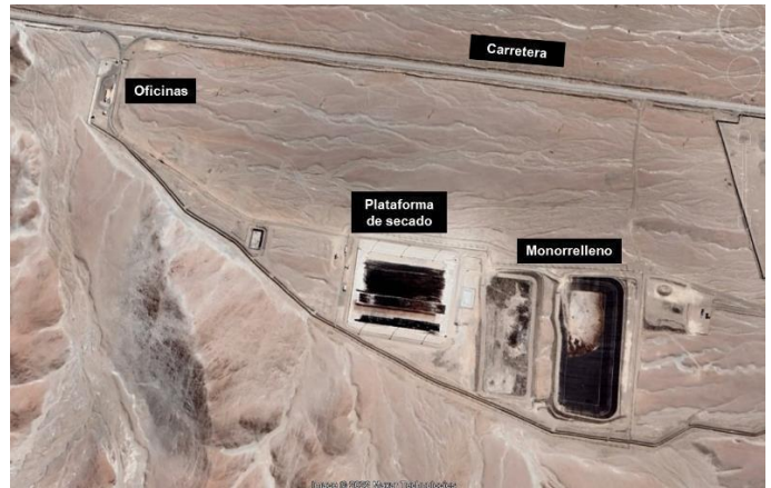
Fig. 1 Instalación de tratamiento y disposición final de lodos
