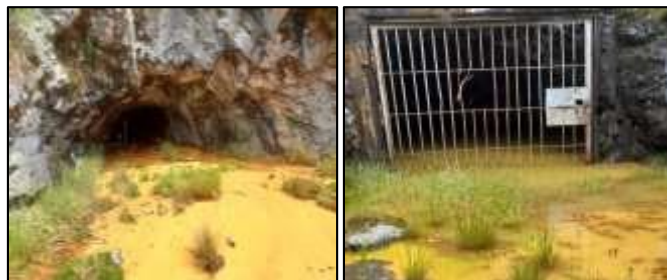
Fig. 1. Pasivo ambiental de Hualgayoc (P1 y P2 respectivamente) con presencia de drenaje ácido de mina (DAM).
