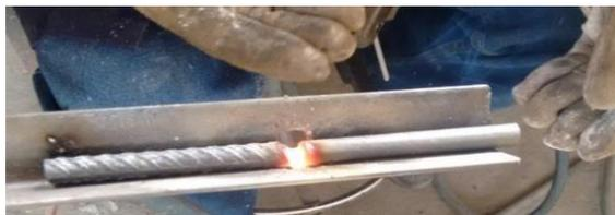
Fig. 12: Soldeo de los aceros A615 con A36 [21]
