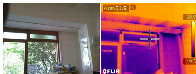
Fig. 7 y 8. Termografía tomada en el ensayo blower door se identifican infiltraciones. Fuente: fotografía y termografía tomada por el autor
