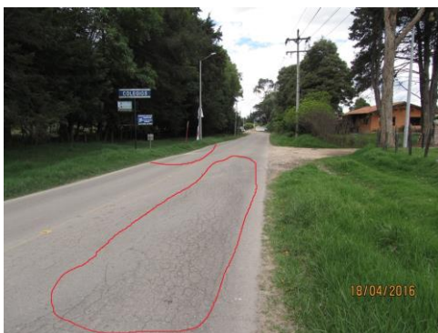
Figura 1: Patologías producidas por procesos de desecación en el pavimento flexible.
