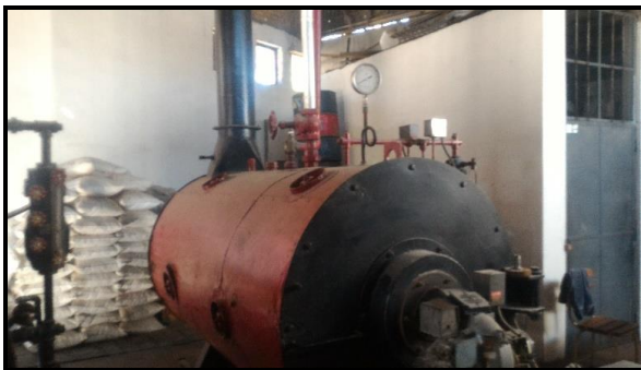
Fig. 2. Caldero piro-tubular del comedor UNSA [5].
